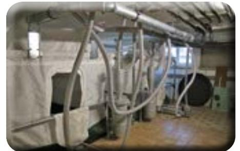
Einbau der Vorratssäcke für die Pellets
