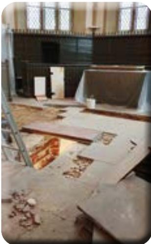
Aufgestemmter Fußboden für die Heizungsrohre
