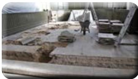
Aufgestemmter Fußboden für die Heizungsrohre
