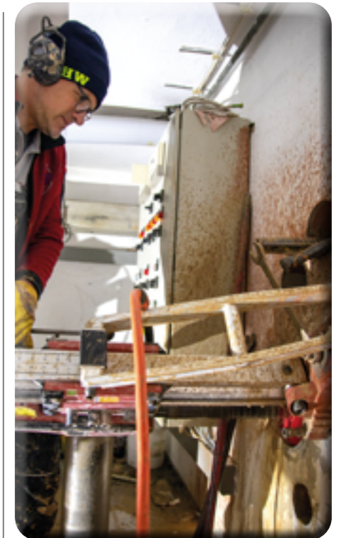
mehrere große Löcher müssen in die über 2 m dicken KirCHFundamente gebohrt werden
