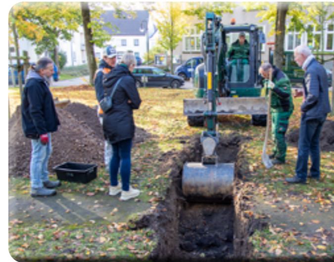
Beginn der Grabungsarbeiten für die neuen Heizungsrohre
