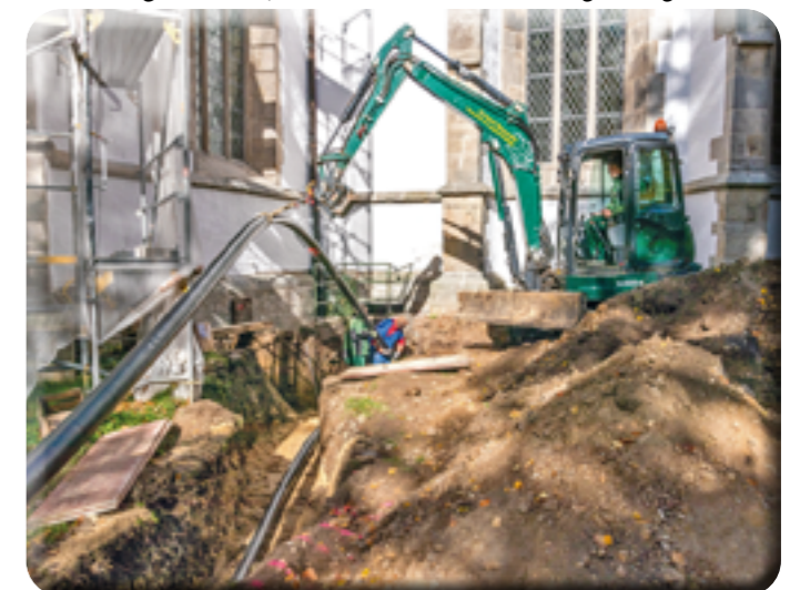
Die neuen Heizungsrohre werden eingezogen
