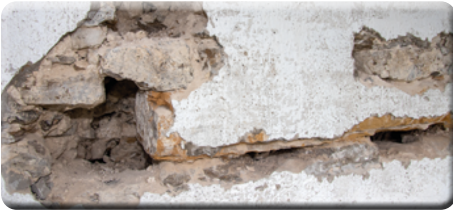
Risse im Mauerwerk werden großflächig ausgestemmt, bevor sie neu verputzt werden. Gut zu erkennen, verbaut wurden einzelne Steine, aber auch meterlange Quader.
